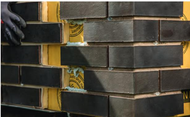
Schritt 5: Einfaches Anbringen der *System-kess-*Platte
