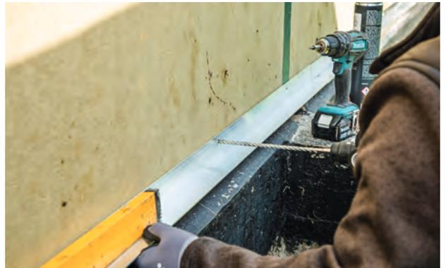
Schritt 1: Setzen der Starterschiene (optional)
