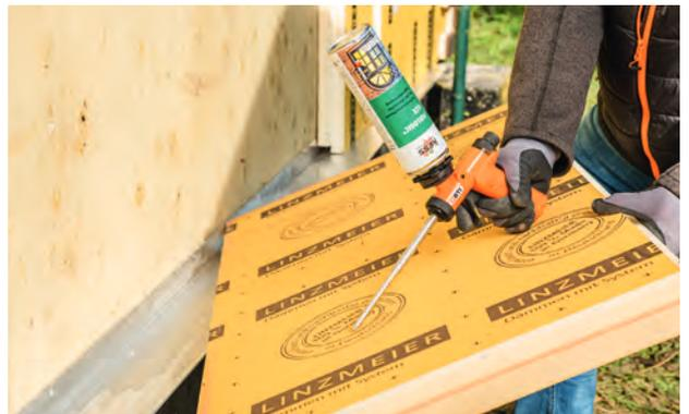
Schritt 2: Anbringen der Dämmung
