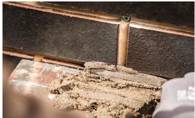
Schritt 8: Verfugen der Klinkerfassade
